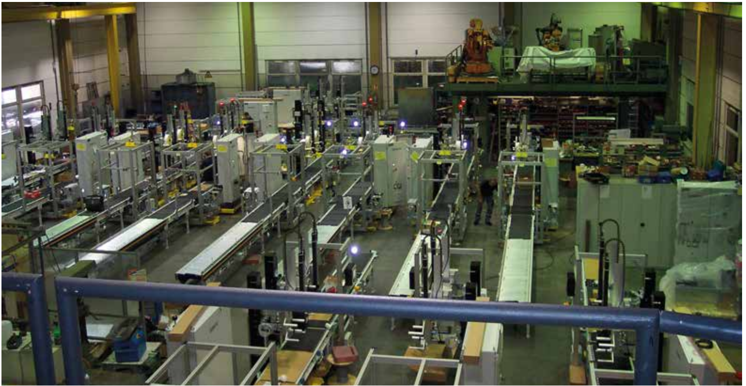
Gleichzeitige Montage von 13 Prüf- und Transportbändern
